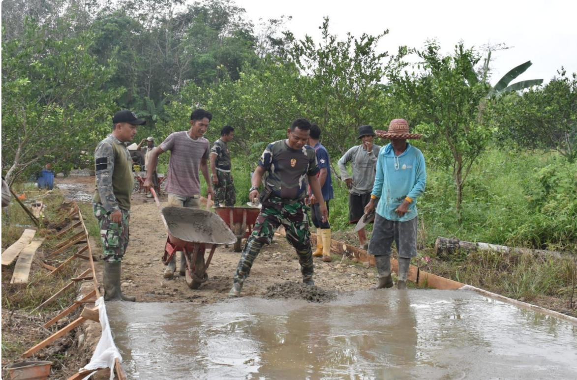
Dalam Pra TMMD tersebut, pekerjaan difokuskan pada pembangunan fisik yaitu Jalan dengan semenisasi sepanjang 2.382 meter, lebar 2,5 meter dan tinggi 20 centimeter yang menghubungkan dua desa di dua kecamatan yaitu desa Hapulung kecamatan Haruyan dan desa Pantai Batung Kecamatan Batu Benawa kabupaten Hulu Sungai Tengah.
